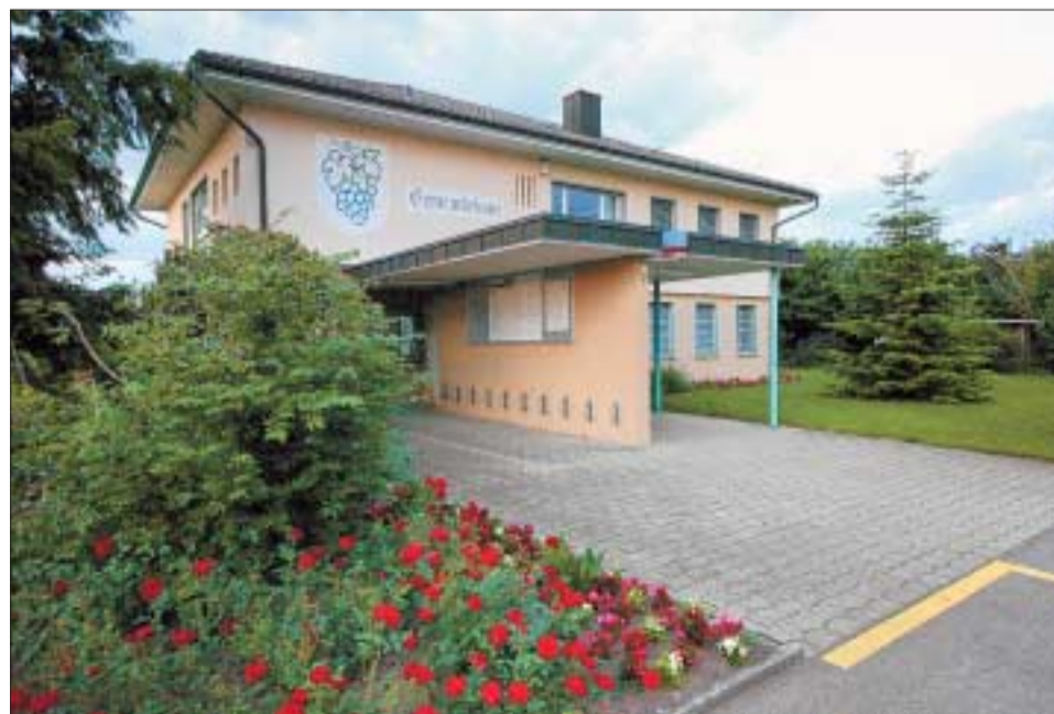
GEMEINDEHAUS WYNAU Es soll mit «vernünftigem» Aufwand saniert werden. JR
