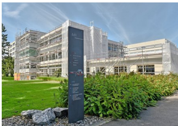
Noch sind die Renovationen am Gymnasium Oberaargau nicht abgeschlossen, rollstuhlgängig sind die Zimmer aber bereits heute.
