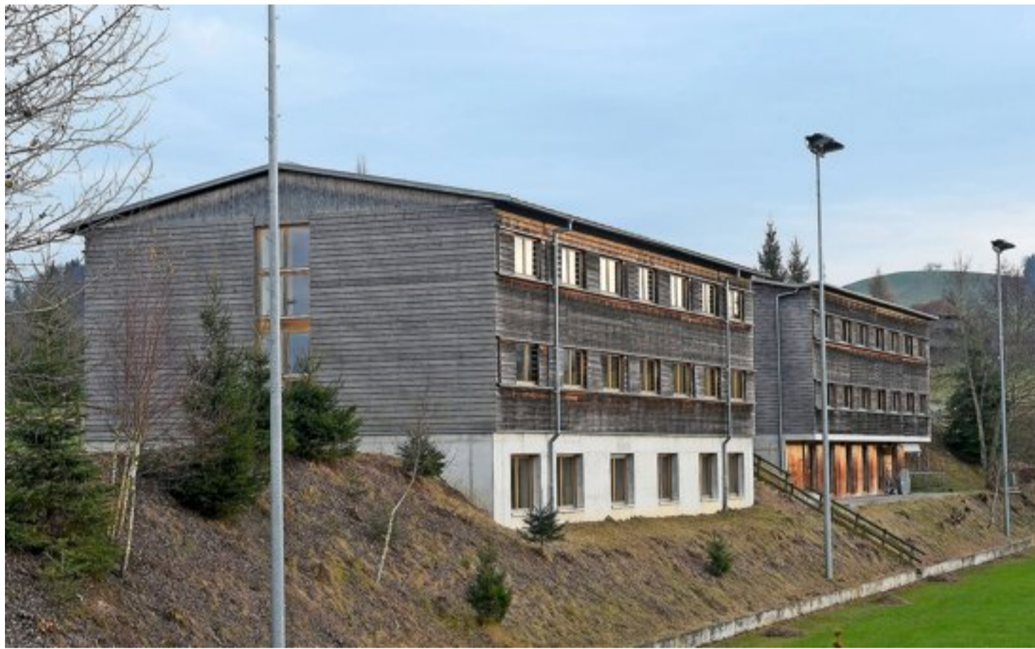
Teil eines Ganzen: Im Unternehmungsgebäude links soll ein Zentrum für unbegleitete minderjährige Asylbewerber eingerichtet werden. Es gehört zum Projekt Campus Perspektiven der neuen Mieterin des Sportzentrums Huttwil.
